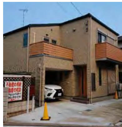
港北区日吉本町 賃貸住宅
